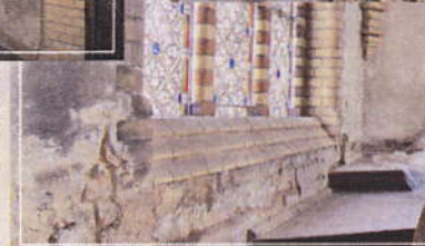
aufsteigende Feuchtigkeit an den Innenwänden, Salpeter
