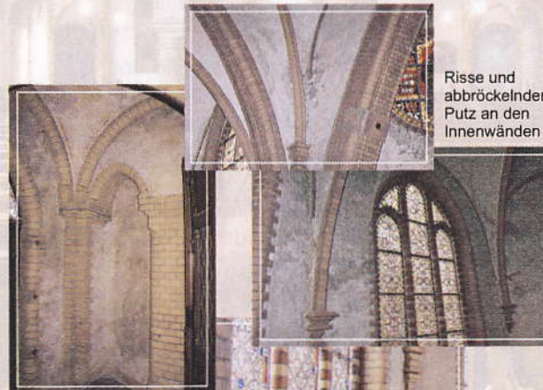
aufsteigende Feuchtigkeit an den Innenwänden, Salpeter
